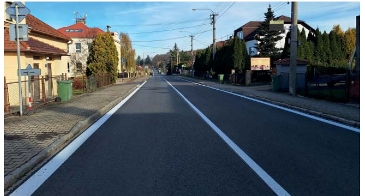
Ulice Staroveská po opravě září novým asfaltem a čerstvě nataženými bílými liniemi.
